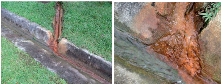
Figura 12.4. Cauce de arroyos de color pardo debido a la conversión del \text{Fe}^{++} a \text{Fe}^{+++} Foto: G. Roldán
