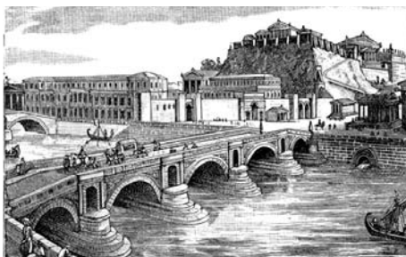
Figura 20.1 Cloaca romana por donde se canalizaban las aguas residuales
