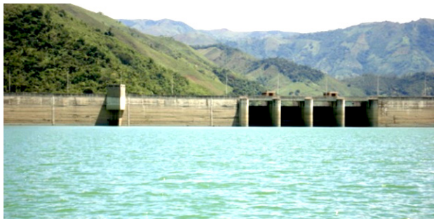
Figura 7.1. Embalse Porce II para generación de energía hidroeléctrica (Río Porce, Antioquia). Foto: G. Roldán
